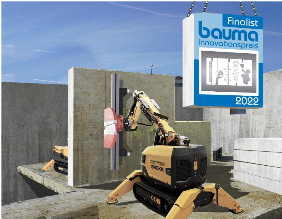
Abbildung 3: Baustellen Setup mit BROKK und Wands ge
