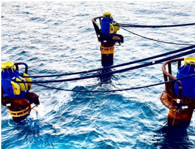
(2) Mit bis zu drei simultan arbeitenden Bohrergeräten werden Pfähle in schwierigen Bodenverhältnissen sicher und effizient verankert. © BAUER Gruppe
